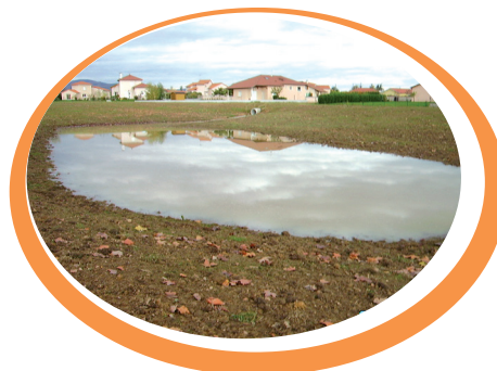
Exemple de bassin de rétention
