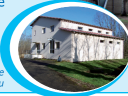
Usine d'eau potable au Coteau
