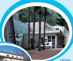
Usine d'eau potable à Renaison
