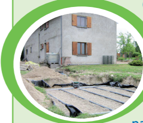
Installation d'assainissement non collectif
